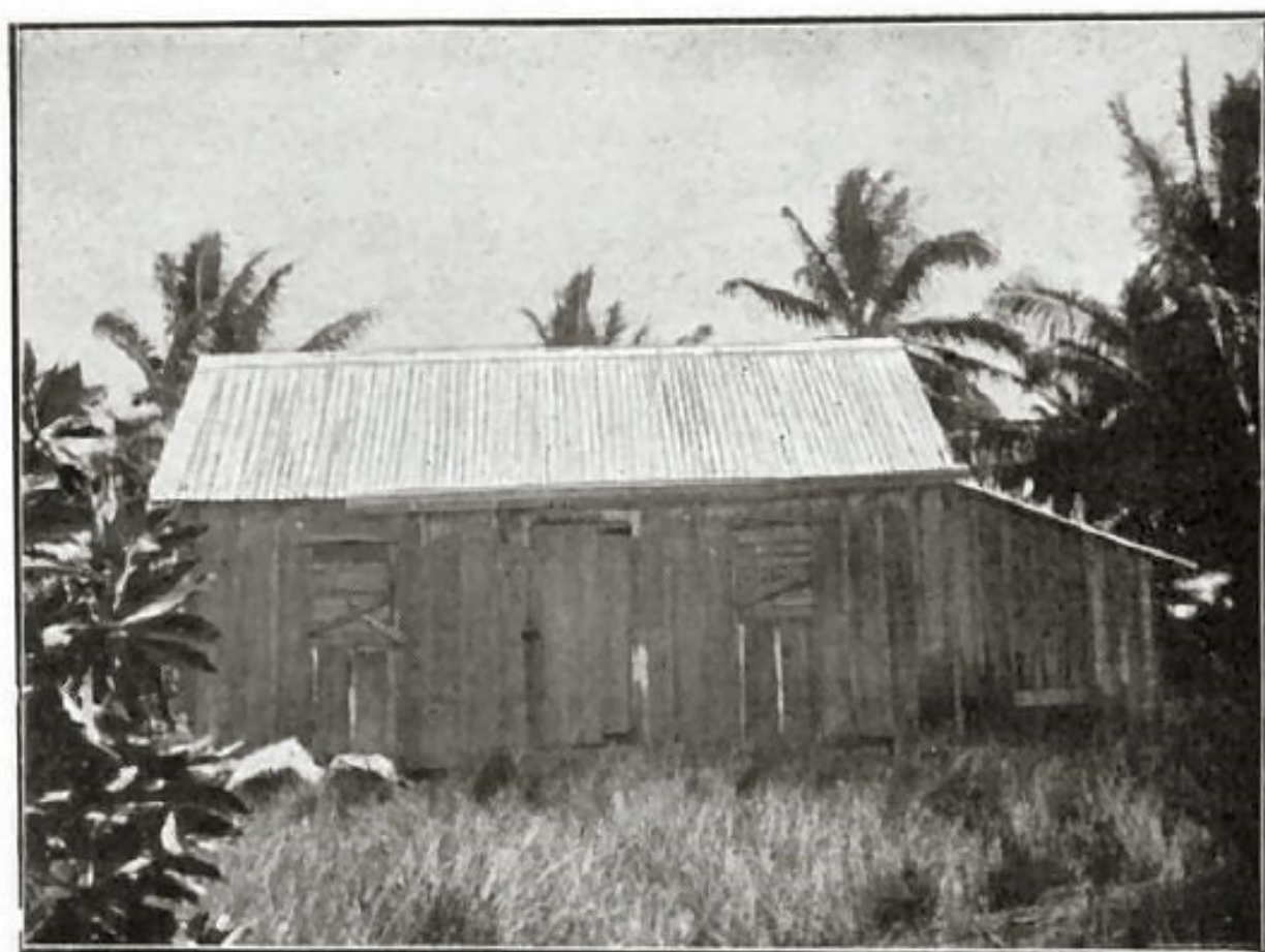
Hangar pour coprah.
