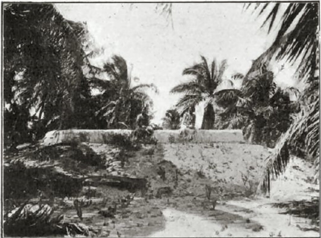
Citerne en ciment.
